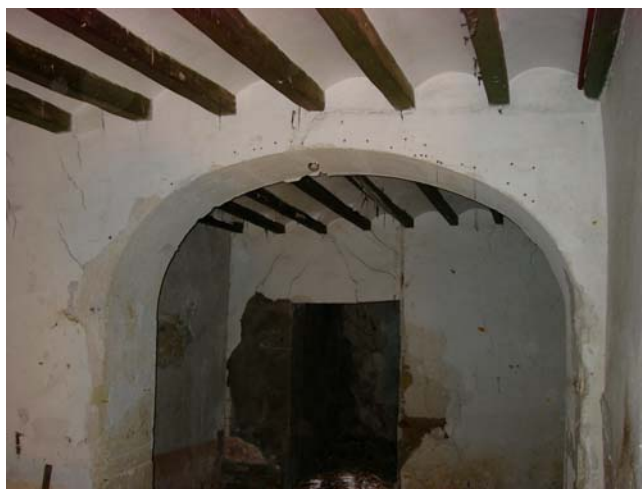
Forjados de viguería y senos de plementería
