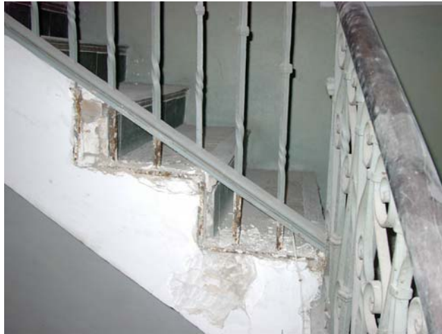
Detalle de su estado
